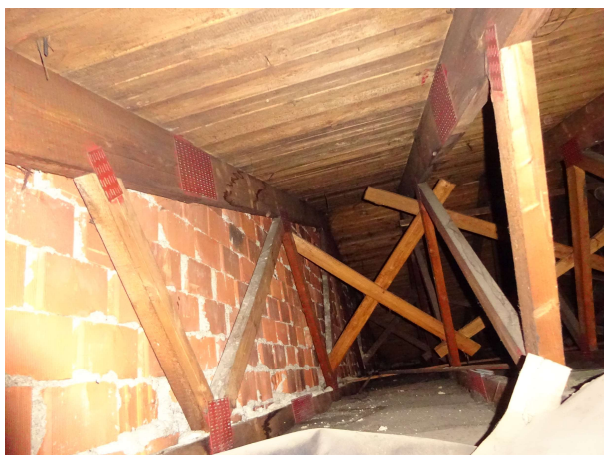
Objekt E - Vazníky ztuženy prkenným diagonálním ztužením
