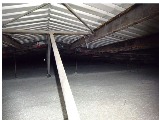
Objekt C - Nosná konstrukce střechy – je nutné provést obnovu nátěru střechy
