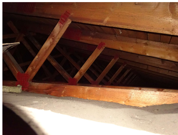
Objekt E - Střecha řešena příhradovými vazníky
